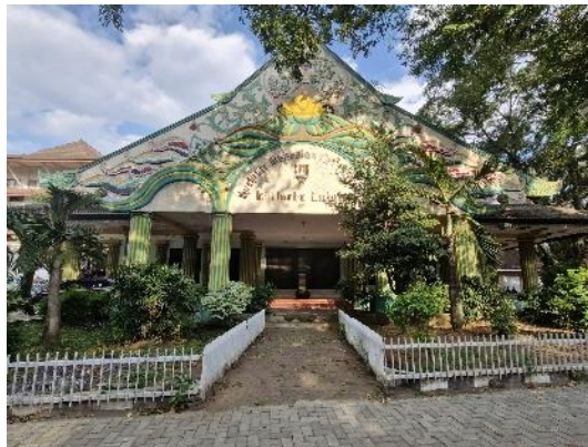
Gambar 1. Gedung Ki Narto Sabdo TBRS (Sumber : Wieke Putri Ainun Nimah, 13 Februari 2025)
