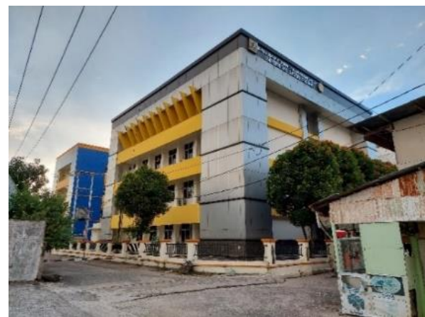
Gambar 2. Foto Gedung Pusat PPG dan UPT-MKU (Purnomo, 2021)
