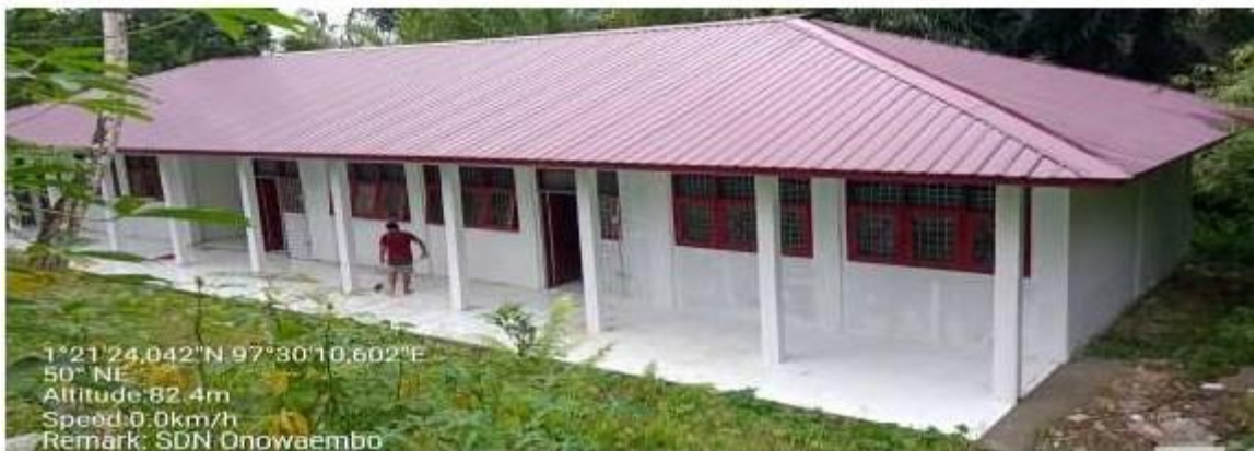
Gambar 6. Gedung Sekolah Setelah Rehabilitasi
