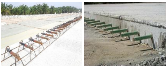
Gambar 11. Pemasangan dowel bar
