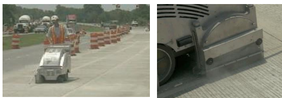
Gambar 16. Pemotongan sambungan beton
