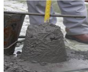
Gambar 13. Pemeriksaan slump beton
