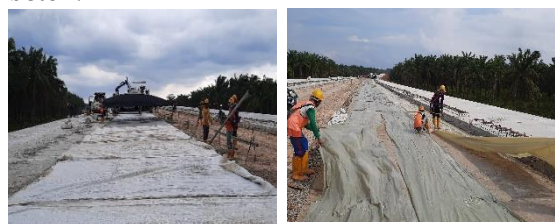
Gambar 9. Pemasangan plastik sebagai bond breaker
