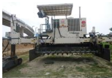
Gambar 8. Pengesetan alat penghamparan
