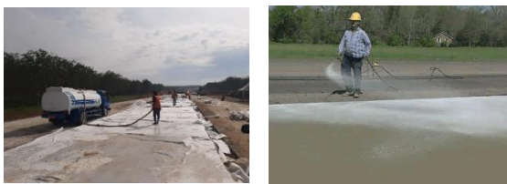
Gambar 17. Perawatan (curing) beton dengan air dan curing compound
