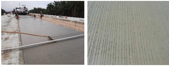
Gambar 15. Pembuatan Grooving
