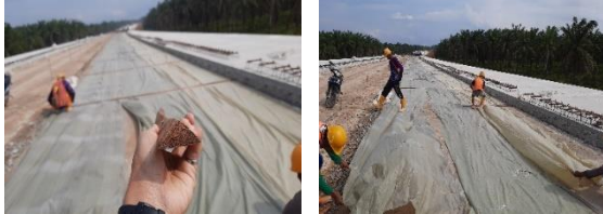
Gambar 10. Pemasangan Pemicu Retak
