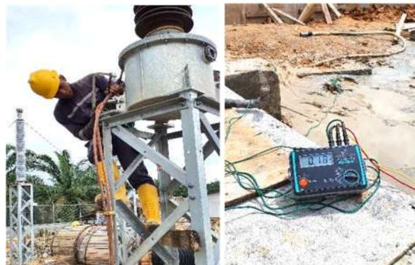
Gambar 9 : Penyambungan konduktor pembumian ke bagian metal peralatan dan pengukuran sistem pembumian
