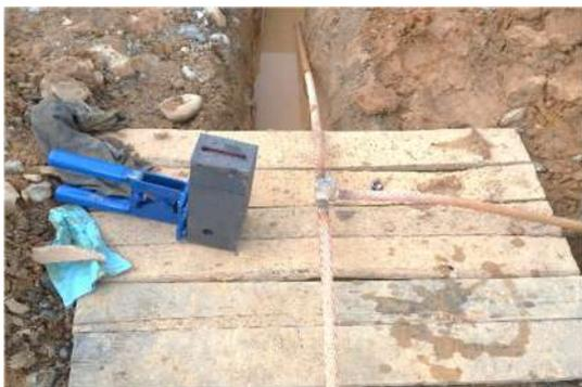
Gambar 8 : Sambungan konduktor menggunakan thermite cadweld
