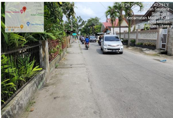
Gambar 3. Kondisi eksisting saluran tertutup Jalan Saudara
