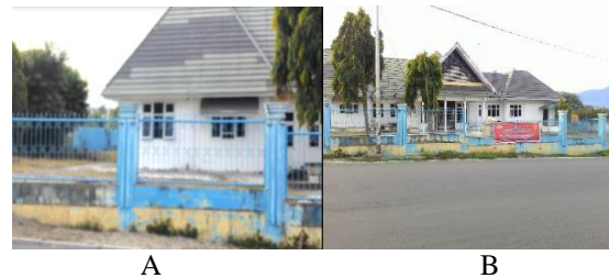
Gambar 3.1 Klinik dan apotek sebelum renovasi (A), Apotek sebelum renovasi (B)
