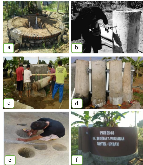
Gambar 4. a) pondasi kolam; b) pembuatan kolam pengendapan; c) pemasangan kolam pengendapan; d) rangkaian kolam pengendapan; e) lubang dasar pengeluaran air; f) kolam siap digunakan
