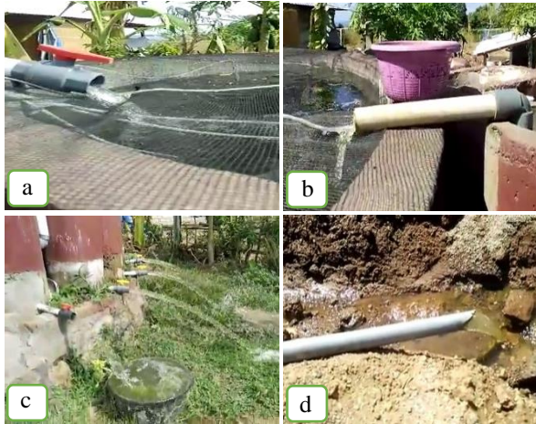
Gambar 5. a) pengisian air; b) air water lift untuk system resirkulasi; c) pembuangan air; d) mengalirkan air ke lahan pertanian.
