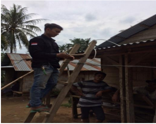
Gambar 15. Pemasangan mini circuit breaker .
