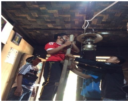
Gambar 16. Pemasangan saklar di rumah warga.
