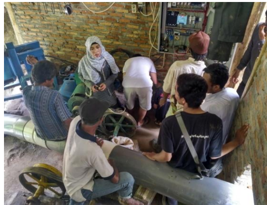
Gambar 13. Perakitan sistem kontrol beban.
