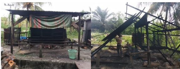
Gambar 1. Pembongkaran rumah asap lama.
