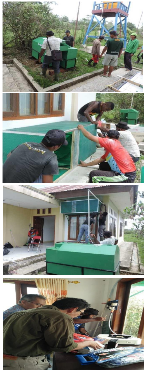
Gambar 1. Pemasangan biodigester portabel dan aksesorisnya.
