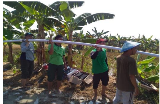
Gambar 6. Pemasangan instalasi Smart Solar Water Pump pada lahan pertanian.
