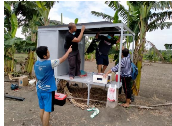
Gambar 13. Kegiatan pemasangan rumah pompa tenaga surya di tengah lahan pertanian mitra.
