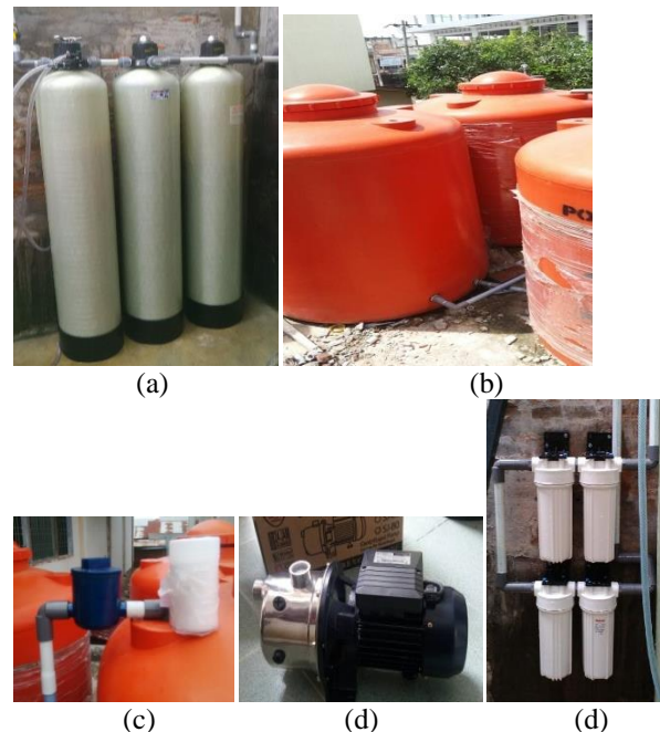
Gambar 4. Peralatan utama yang digunakan (a) Tabung filter air fiber D 13", H 140 cm, kapasitas 115 kg; (b) Tangki air polytech 1100 L; (c) Housing kaporit; (d) Centrifugal pump otomatis 40 L/menit; (e) Filter cartridge 0,5 \mu , kapasitas 5-10 m 3 /hari.
