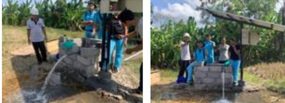
**Gambar 16.** Pengetesan Pemasangan instalasi plumbung dan pengisian air
