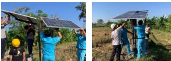
**Gambar 11.** Pemasangan modul
