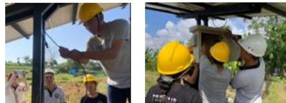
**Gambar 14.** Pemasangan instalasi listrik dan *controller*
