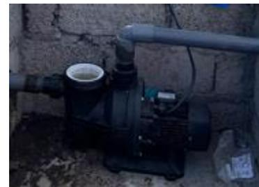
**Gambar 13.** Pemasangan Solar pump
