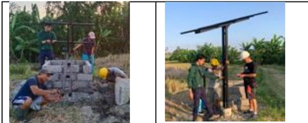
**Gambar 11.** Pemasangan rangka dudukan panel surya
