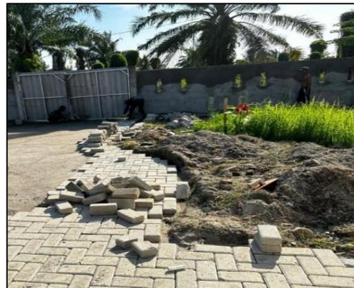
Gambar 5. Pembuatan jalur paving block
