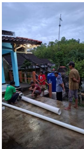
Gambar 2. Pemasangan Instalasi Penampungan dan Penyaringan Air Hujan
