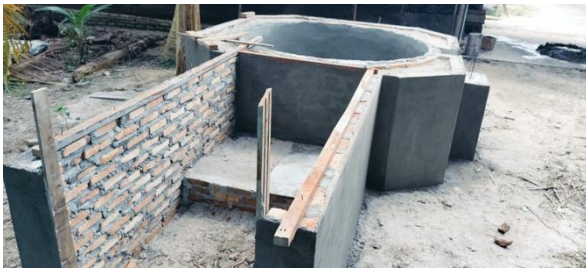
Gambar 3. Pembakaran Arang Kondisi 70% Selesai
