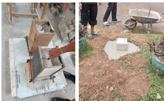
Gambar 2. Proses Pengecoran (a) dan Pemasangan (b) Titik Benchmark
