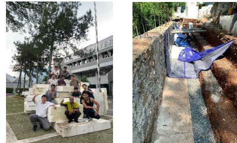
Gambar 8. Pengiriman Material Geofom dan Tumpukan Geofom dialasi Terpal
