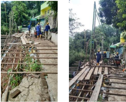
Gambar 6. Pekerjaan Persiapan dan Pekerjaan Strauss Pile
