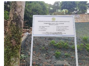
Gambar 13. Pekerjaan Geomat pada Lereng
