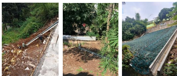
Gambar 12. Pekerjaan Saluran Air pada Lereng
