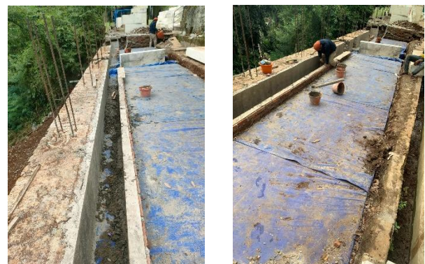
Gambar 9. Lapisan Urugan Batuan sebagai Sub-base Jalan Penghubung
