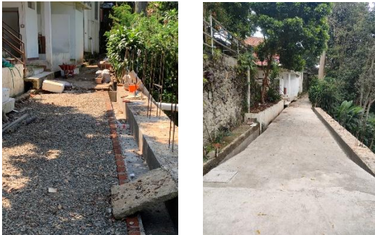
Gambar 11. Perapian Saluran Terbuka dan Rekonstruksi Jalan Penghubung
