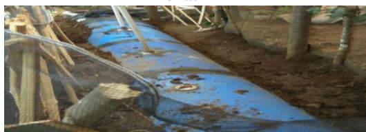
Gambar 5. Demplot Biogas dari Kotoran Sapi Lokasi 2
