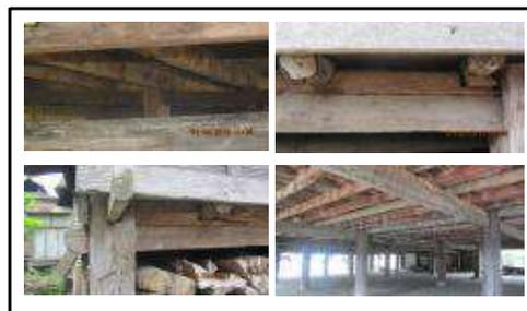
Gambar 3. Bentuk susunan balok lantai pada rumah tradisional di Mandailing
