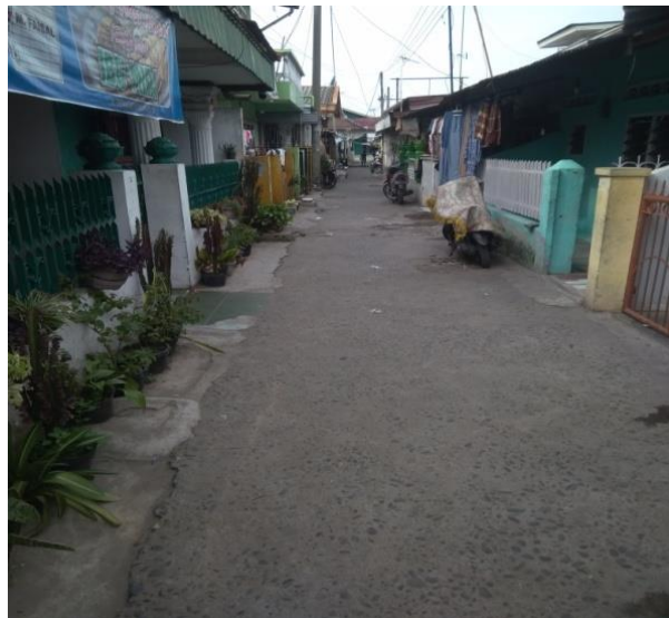
Gambar 1. Kondisi Bangunan Gedung
